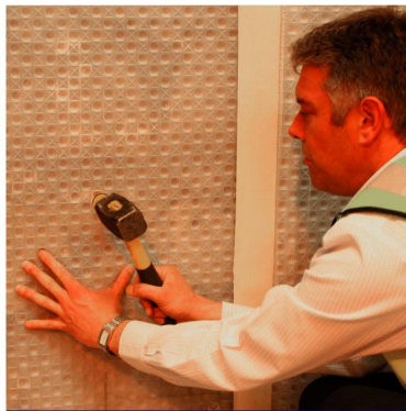
5) Fix brick plugs 600mm apart
